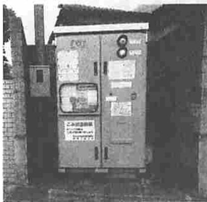
設置されているゴミポスト
