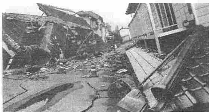
【1階部分が潰れた家】
