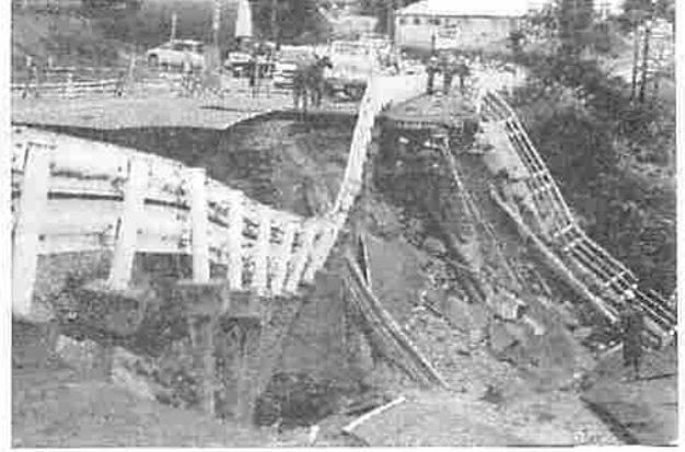
【新潟中越地震時の復旧作業の様子】
