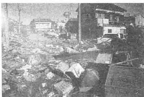
【旭市の津波被害の様子】
